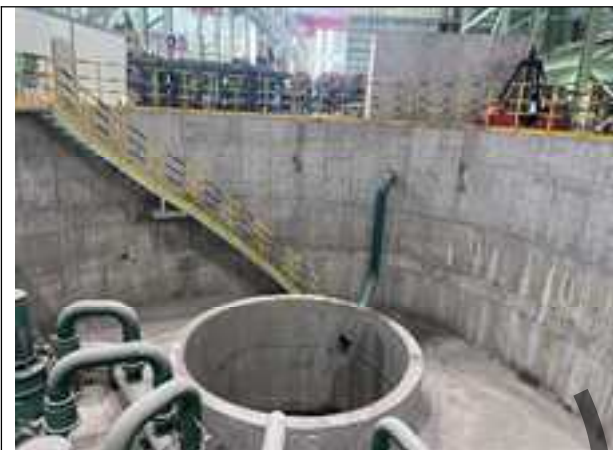
连铸浊环水旋流井(隔油沉淀)
