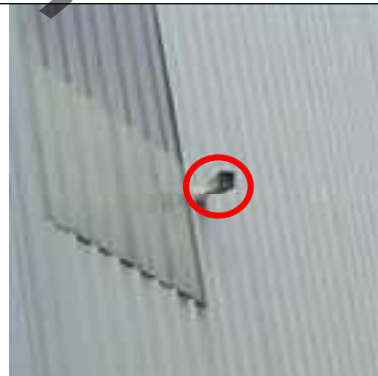
图 4.1-15 烟尘自动抓拍功能的高清视频监控设施
