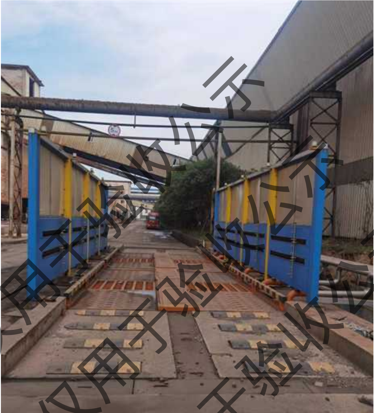
图 4.2-3 已建一座洗车台
